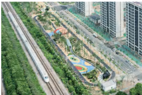
城际铁路北侧口袋公园（新闸街道供图）
