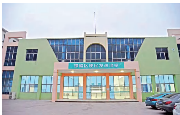
▶ 12月28日，钟楼区便民发热门诊正式运行
