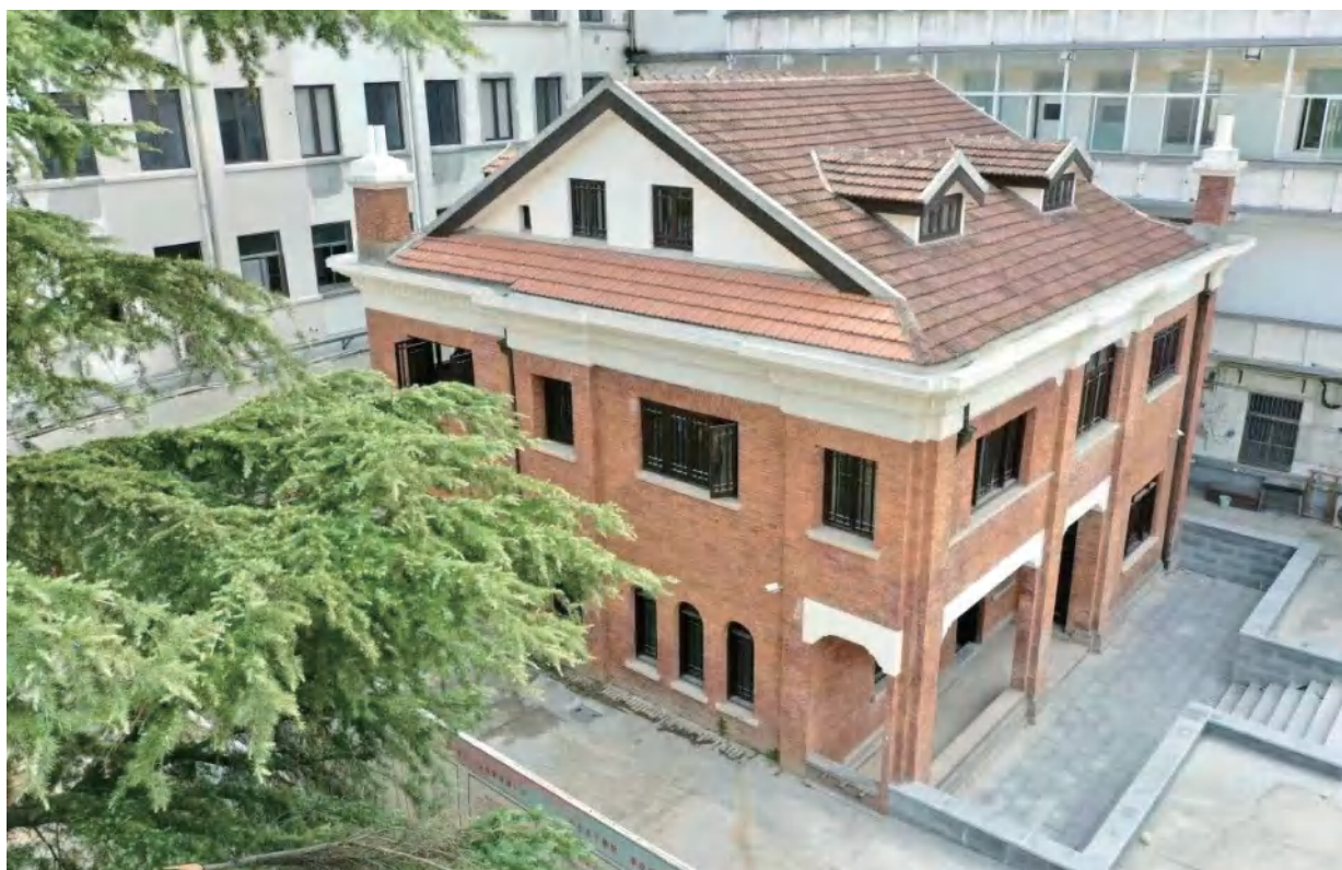
▲ 2022年5月，庄蕴宽故居修缮完工
