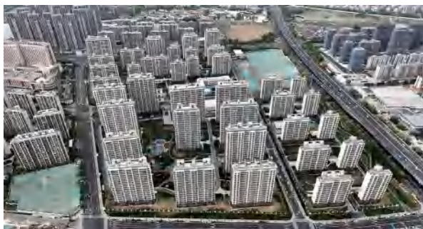
2022年12月底，清云澜湾大板房基本竣工 (新运城市发展集团供图)
