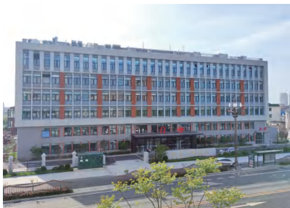
邹区镇卫生院新大楼 (区卫健局供图)
