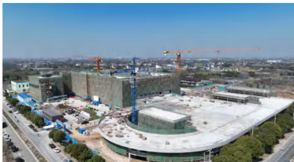
航空技校项目创“拿地即开工”新纪录 [高新园（邹区镇）供图]
