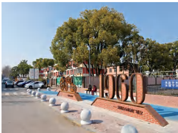
改造后的冶金新村老小区 (新闻街道供图)
