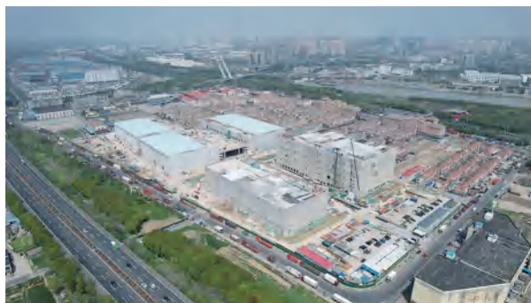
2022年3月1日，新运冷链项目开工 (新运城市发展集团供图)
