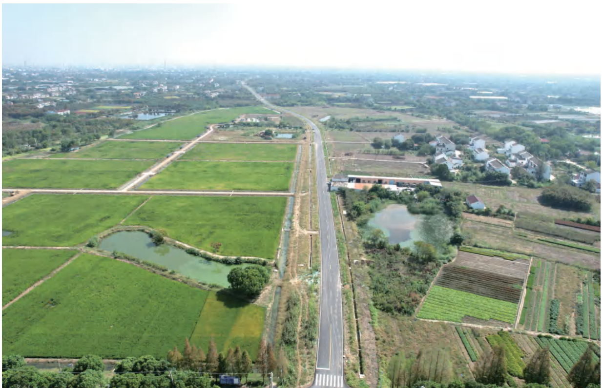
▲ 9月29日，钟楼区南环线（德裕路—S239）路段全线建成
