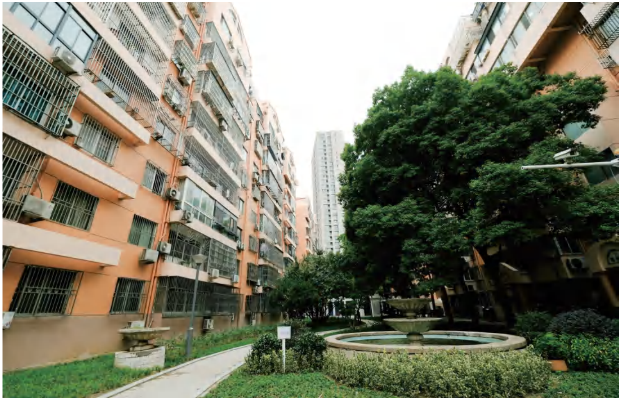
▲老旧小区改造提升工程
