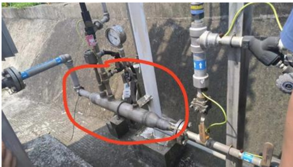
低温液化气体气化段短接管
