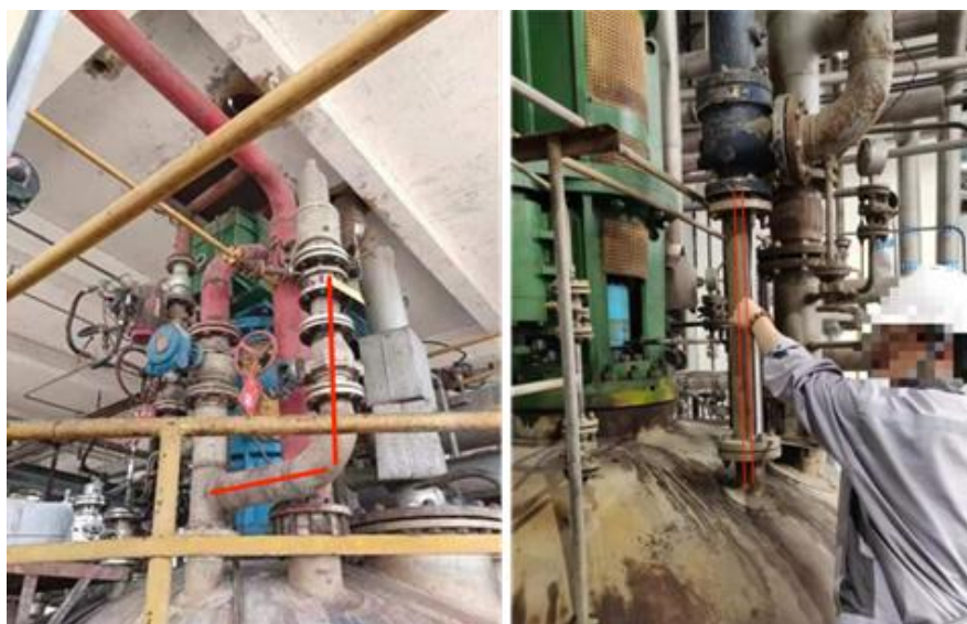
设备至安全阀连接短接管
